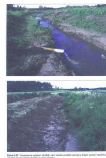
Kuva 8.2. Tulvatasanne onkin tehokas väline eroosiota vähentämään ja virtausnopeutta pienentämään. (Kuva: Ika-Laitinen)
